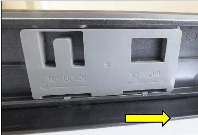
Kunststoffschieber nach rechts schieben = „Lüftungsstellung“
