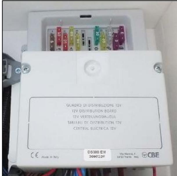
12 V-Sicherungskasten mit Verteilerfunktion (Abb. beispielhaft)
